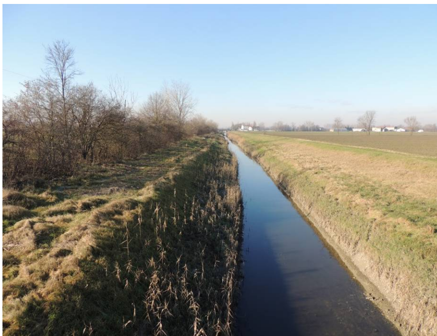
CABM - Collettore Acque Basse Modenesi.
